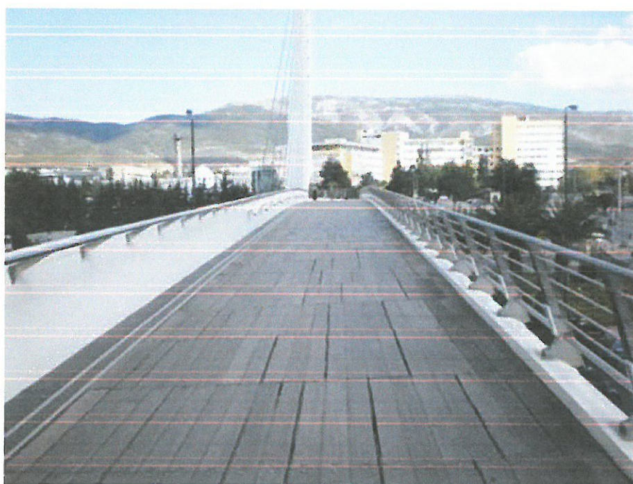
Εικ. 4. Ακατάλληλη εισαγόμενη ξυλεία ξυλοτόπων από ερυθρελάτη
